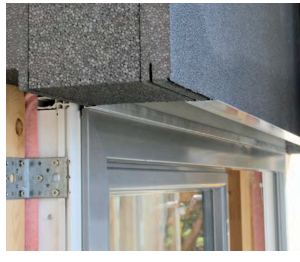
Effektive Fensterrahmenüberdämmung bei einem Kindergarten in Krumbach.
