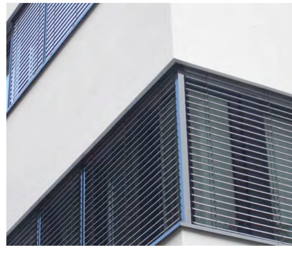
Das vorgefertigte Eckelement in der gewünschten Dämmstärke ermöglicht die thermisch korrekte Eckdämmung.
